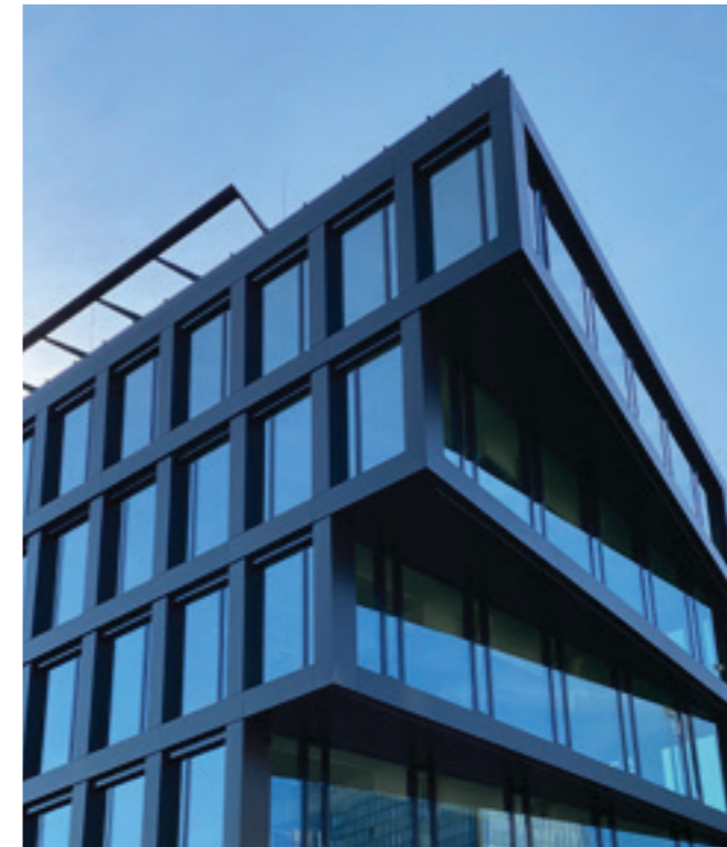
MERCATORSTRASSE 1 (MERCATOR ONE) CUBION vermietet rd. 3.500 m 2 Bürofläche an Sanvartis
