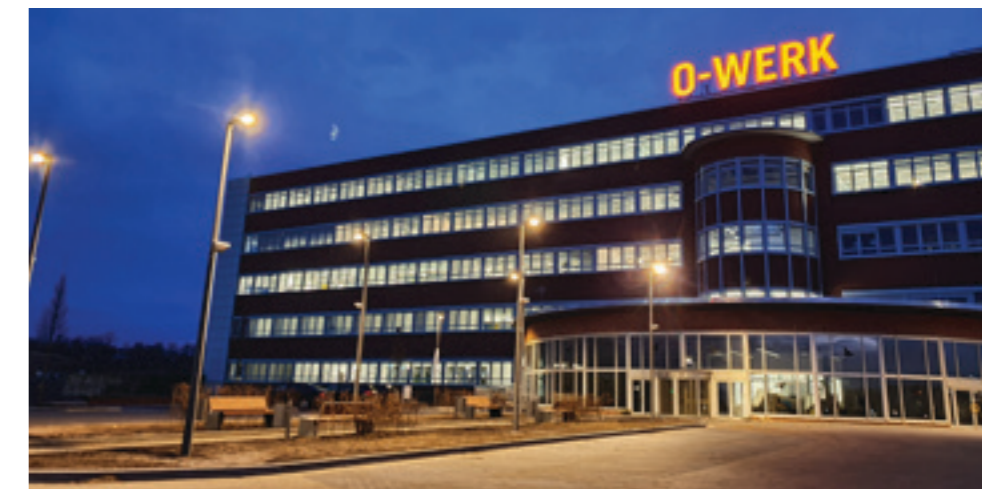
OPELRING 1 (O-WERK) Das größte im Jahr 2020 fertiggestellte Objekt umfasst rd. 13.000 m 2 Bürofläche – Ein Projekt der Landmarken AG
