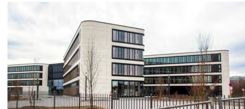
ROBERT-SCHUMAN-STRASSE Amprion-Zentrale Größte Fertigstellung 2018 über rd. 21.000 m 2
