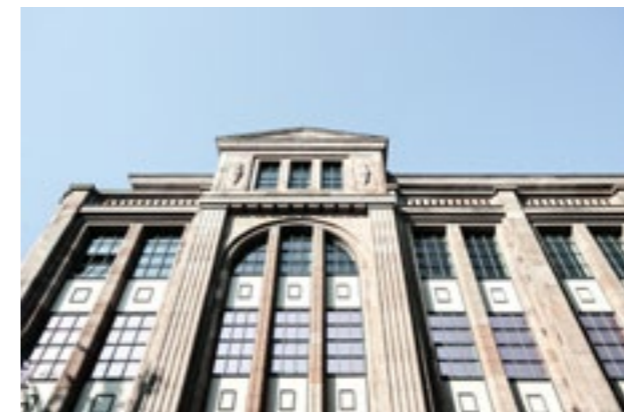
KORTUMHAUS, HARMONIESTR. 1/ GRABENSTR. 12 CUBION vermittelte im Alleinauf- trag Mietverträge über rd. 2.700 m 2 Bürofläche
