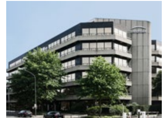
HOHENZOLLERNSTR. 24 CUBION vermietete 2.700 m 2 an die VANAD Group Deutschland GmbH
