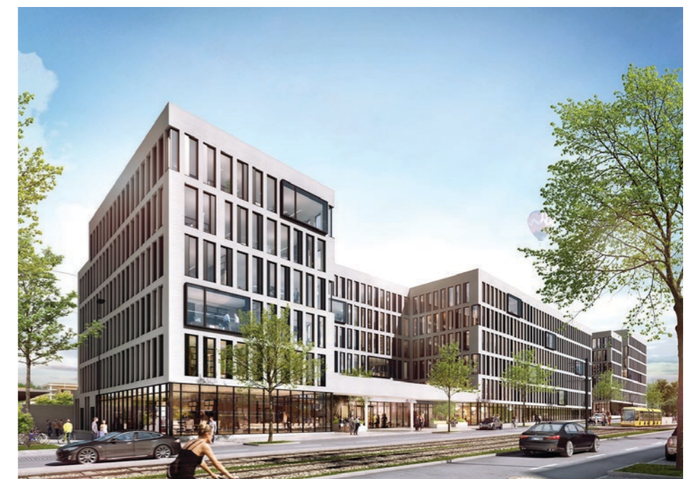
HACHESTRASSE Projekt TRIUM-Essen von Aurelis Alleinvermietungsmandat CUBION
