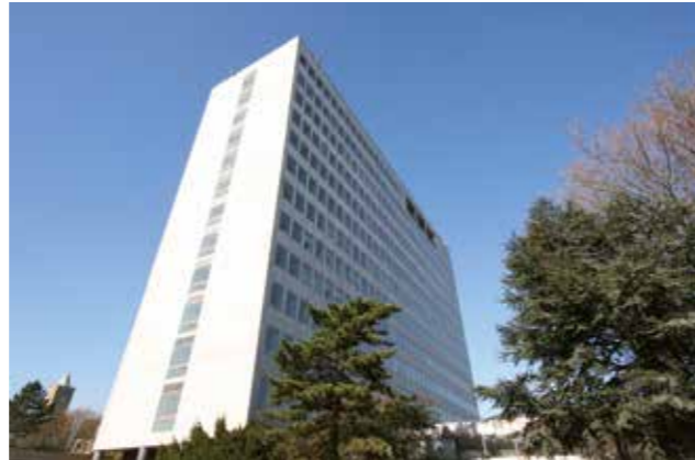
Alleestr. 165, Bundesanstalt für Immobilienaufgaben mietete für Nutzung durch Bundesamt für Migration und Flüchtlinge rd. 8.600 m²
