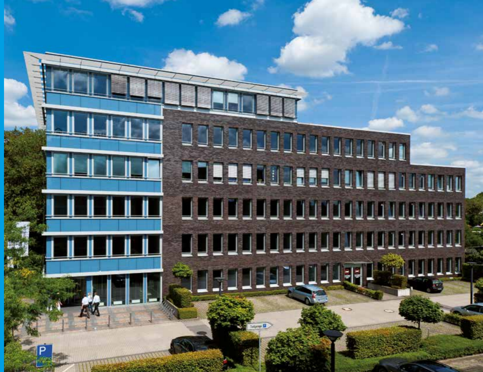
Semerteichstr. 54-56, BAD Gesundheitsvorsorge mietete ca. 1.100 m 2 über CUBION
